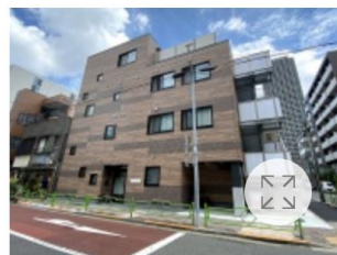
さくらさくみらい東仲通り [画像のクリックで拡大表示]
