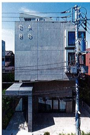
複合ビル「CABO uehara」(東京都渋谷区)
