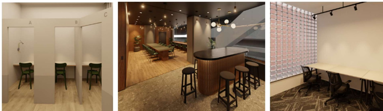
1F のリニューアル工事
